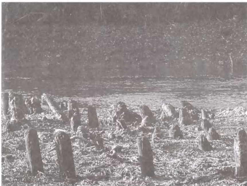
Рис. 18. Деревянные столбы – опоры старого моста
