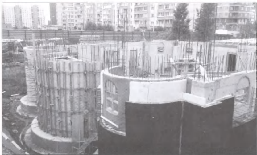
Возведение храмового комплекса в п.Коммунарка. 2011 г.
